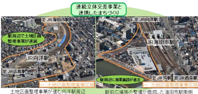
土地区画整理事業が進む向洋駅周辺 駅前広場等の整備が概成した海田市駅南側
