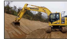
ICT建設機械による施工
