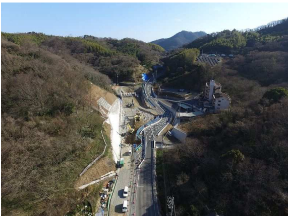
起点側（因島南 IC 側）の工事状況 [令和2年2月]
