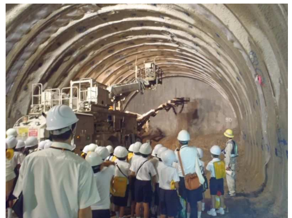
因北小学校児童によるトンネル工事見学の様子 [平成30年9月]
