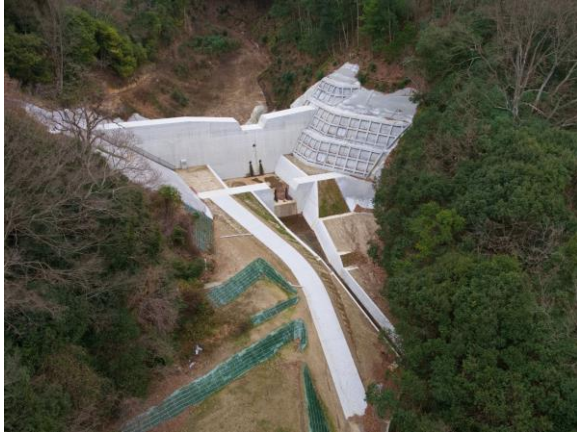
県：砂防激甚災害対策特別緊急事業 熊崎川 (広島市安芸区)
