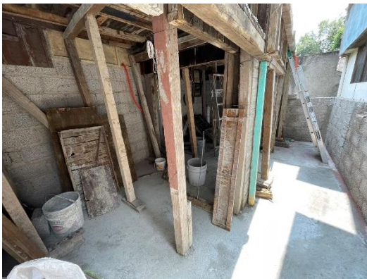
改修中のプレハブ小屋
