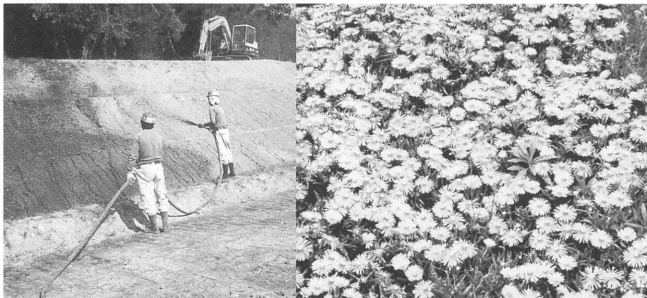
マツバギクによる大型法面の雑草制御（左：切断茎葉吹き付け状況 右：開花状況）
