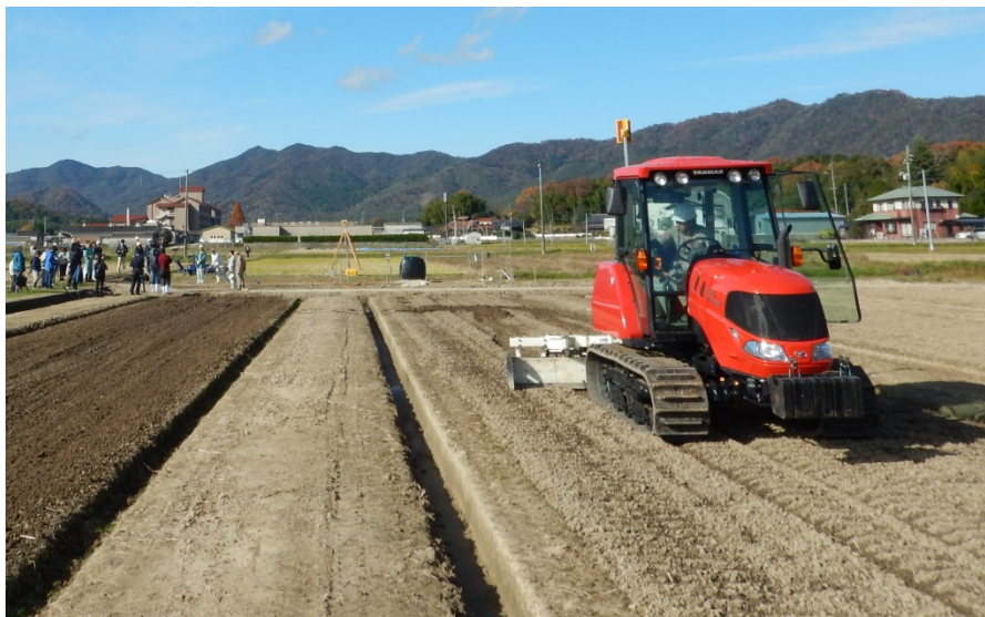
レーザーレベラーによる緩傾斜施工の様子
