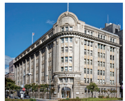
神戸支店 所在ビル
