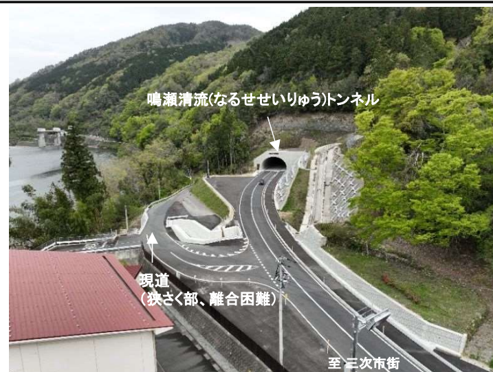
整備後(令和5年3月)
