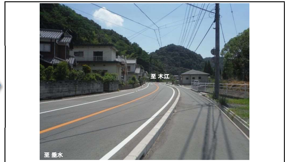
整備後(令和5年5月)
