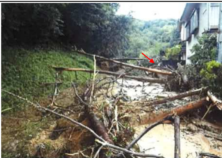
整備前(平成30年7月)
