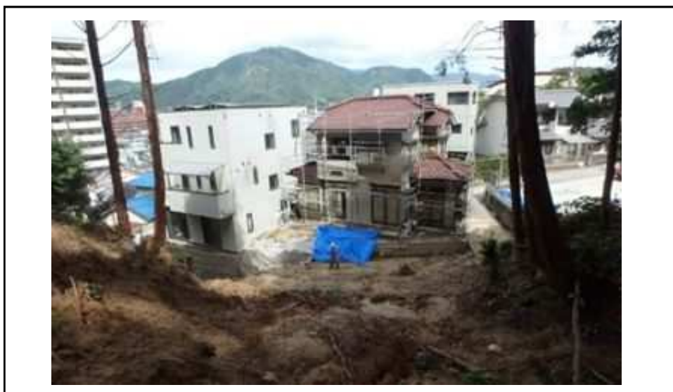
整備前(平成30年7月)
