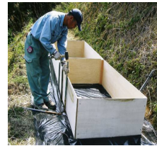
④パイプ打ち込み
