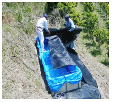
⑦遮光ネット張り
