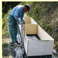
③パイプ打ち込み
