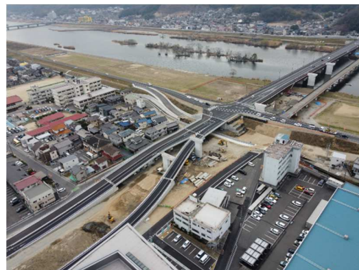
施工状況（草戸町周辺）
