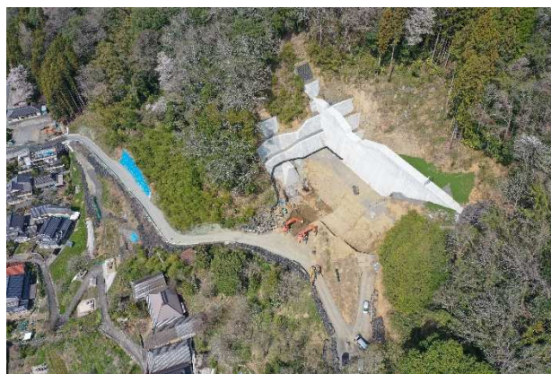
宮ノ間川 砂防激甚災害対策特別緊急工事 (府中市河佐町 施工中)
