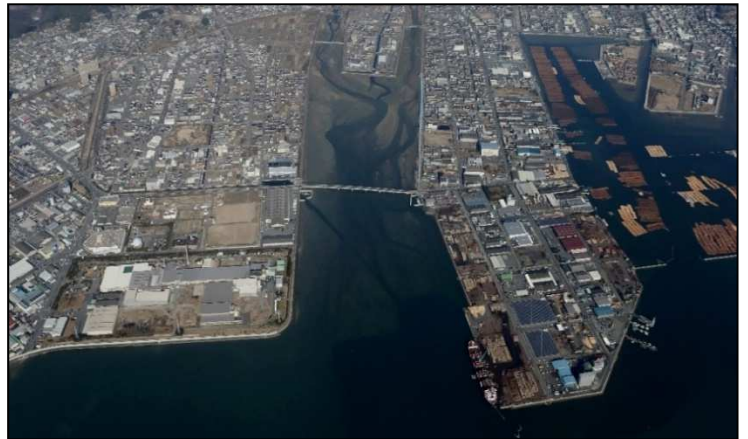
尾道糸崎港（機織地区）
