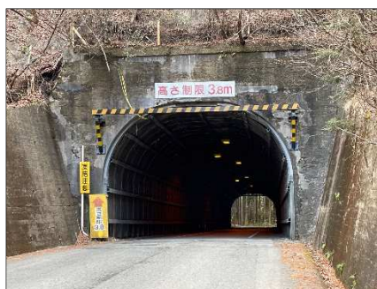
長者原トンネル
