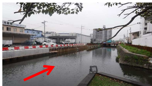
中流域工事（福山市引野町）
