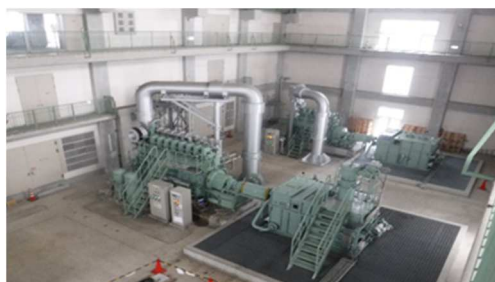
ポンプ増設工事（手城川排水機場内）
