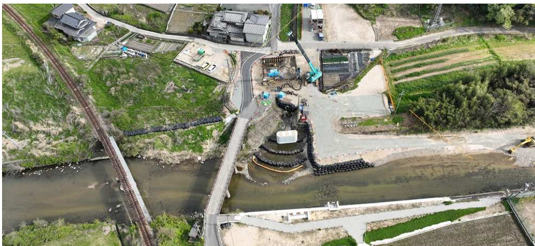
（新）僧殿橋右岸橋台工事
