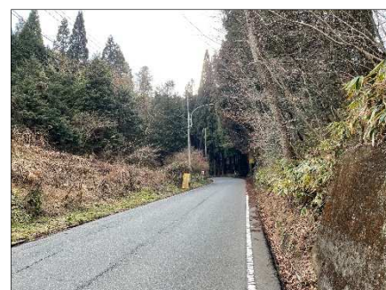
終点側（トンネル東側）
