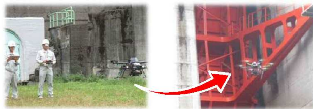
ドローンを活用した施設点検
