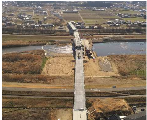
施工状況（福山市駅家町）
