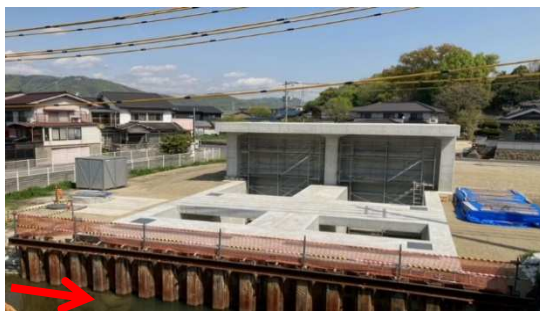
（仮称）福川排水機場（福山市神島町）
