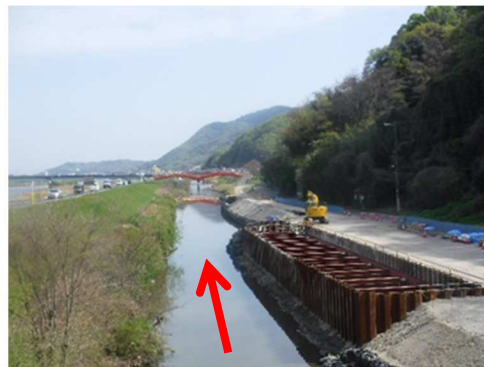
用水管渠敷設工事
