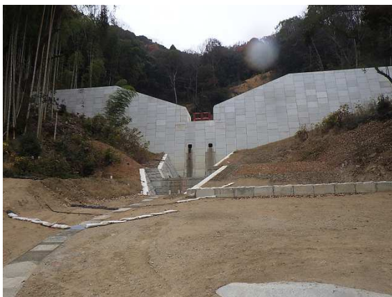
荻之尾川隣 災害関連緊急砂防工事 (福山市神村町 令和 3 年 12 月完成)
