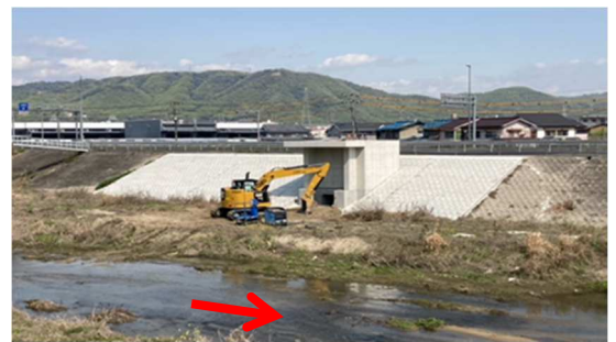
吐出樋門（瀬戸川）
