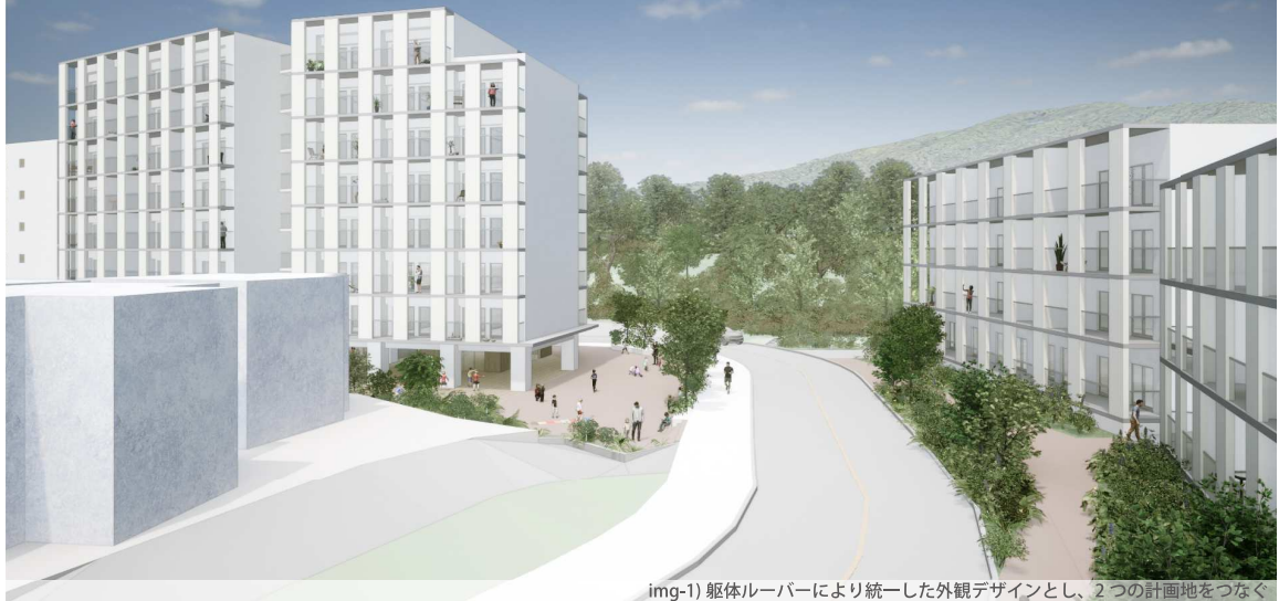
img-1) 躯体ルーバーにより統一した外観デザインとし、2つの計画地をつなぐ
