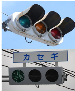
【信号機のLED化】 エネルギー消費量削減 のための信号機LED化
