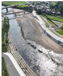
【防災機能強化】 河川改修やため池の 整備
