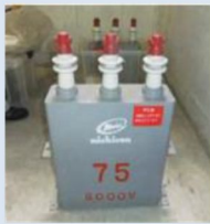
電力用コンデンサー
