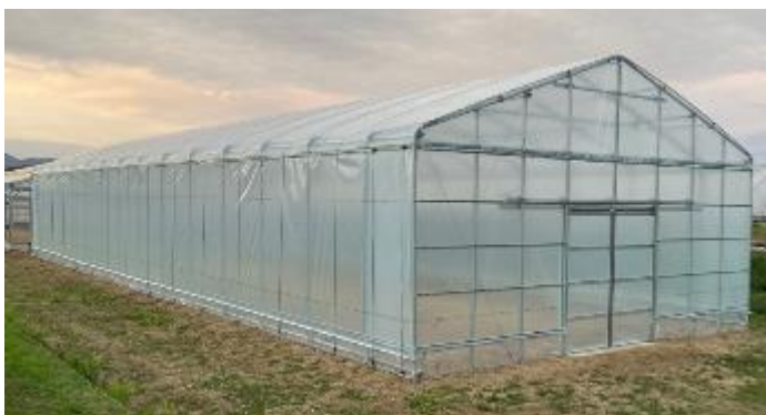
足場管ハウス外観
