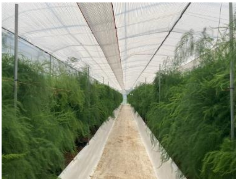
高軒足場管ハウス
