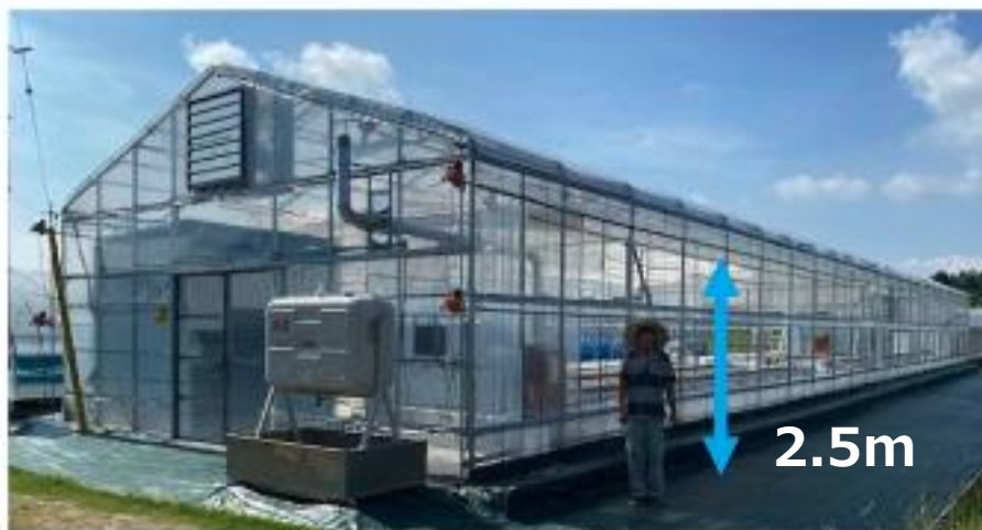
【足場管ハウス】
