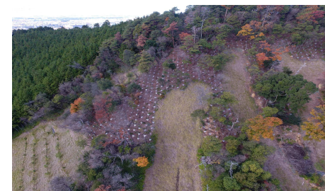
斜面崩壊後の崩壊地周辺の拡大崩壊防止を目的として採用された事例（高所で急峻な施工条件）
