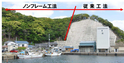
高台に建つ大学周囲の斜面全体に対する急傾斜対策に採用された事例（レッドゾーン解除）
