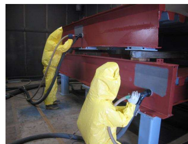
（プラストの投射作業）
