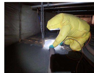
（塗膜くず、研削材の回収作業）
