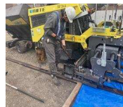
・アスファルト敷き均し
