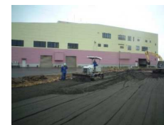
路床材（建築物の外構工事）
