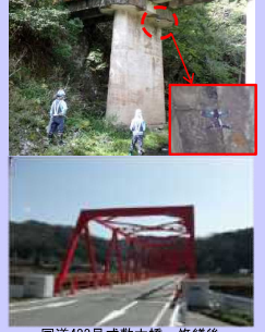
国道433号式敷大橋 修繕後
