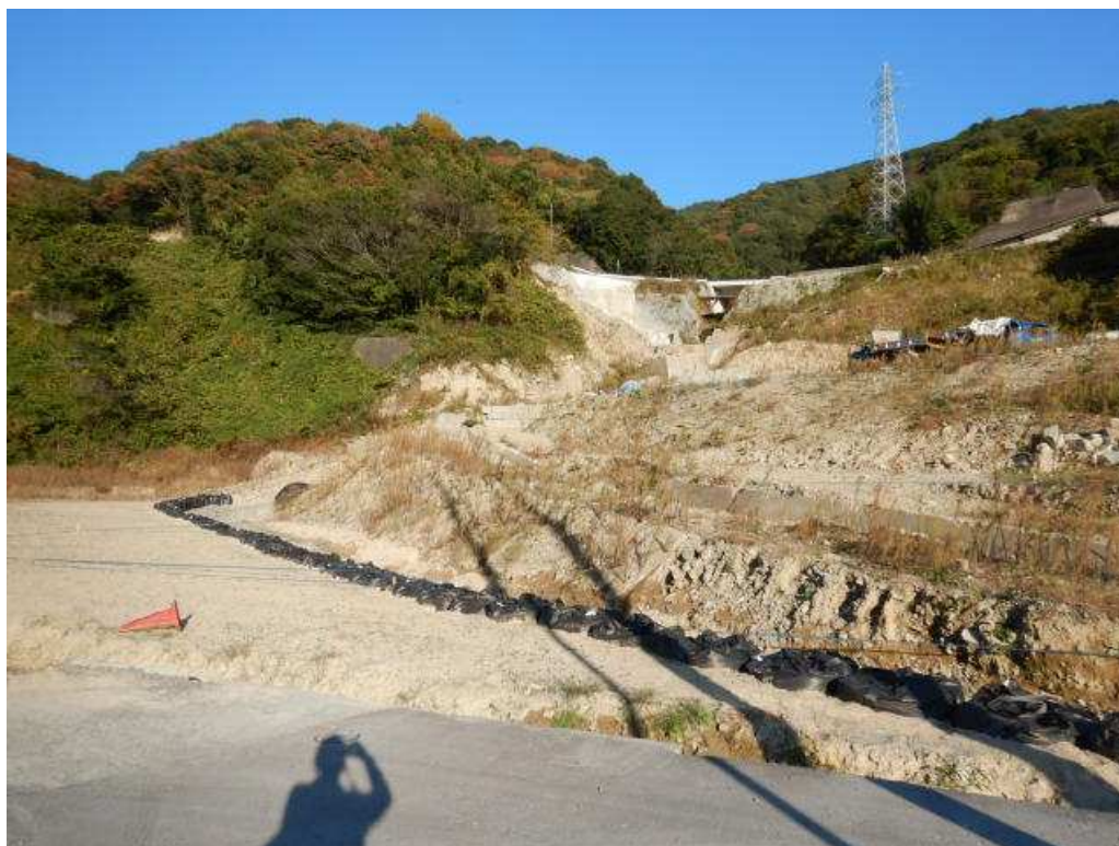
【下流側 着工前】
