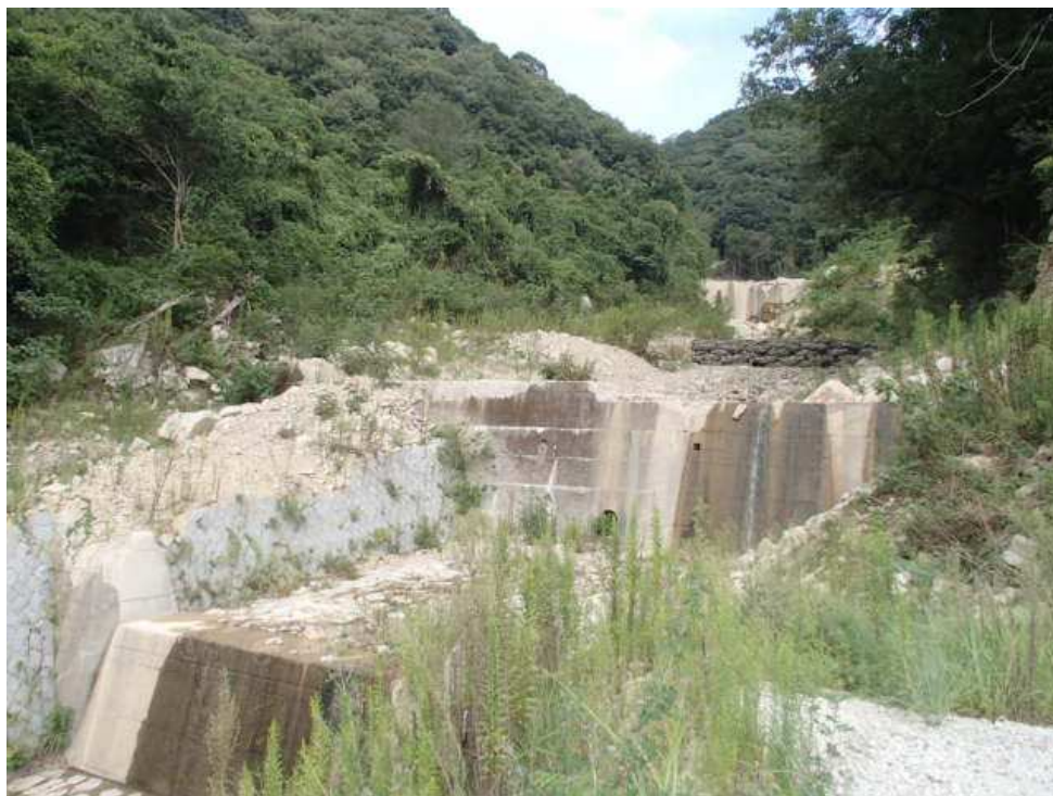
【上流側 着工前】
