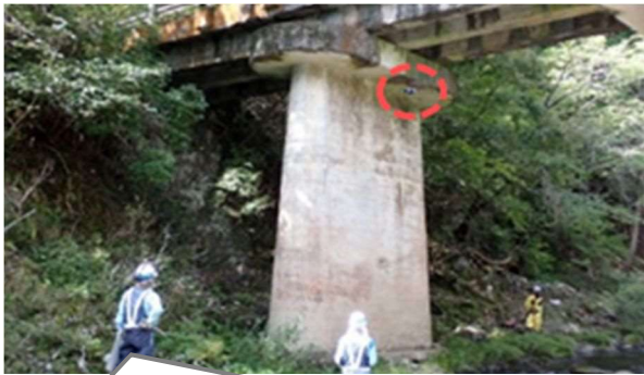
ドローンを活用した施設点検を開始し点検を効率化 (R5.6)
