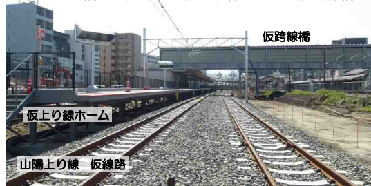
新しく整備した向洋駅の仮上り線ホームと仮跨線橋
