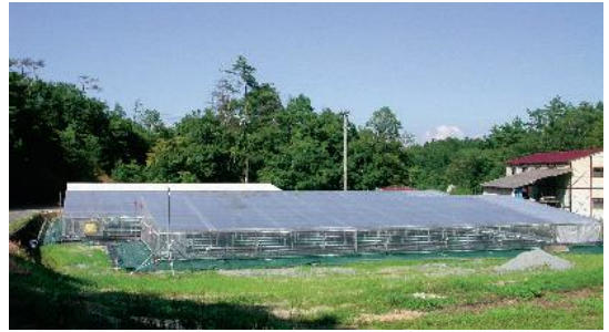
図1 低棟ハウスの実証施設
