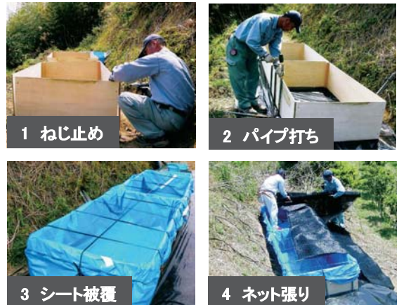
図1 組立式天水槽の現場での設置作業
