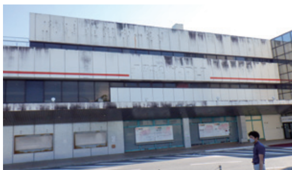
景観整備前（広島ヘリポート）
