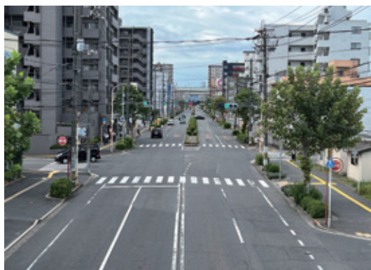
舗装補修前（中2区中島吉島線）
