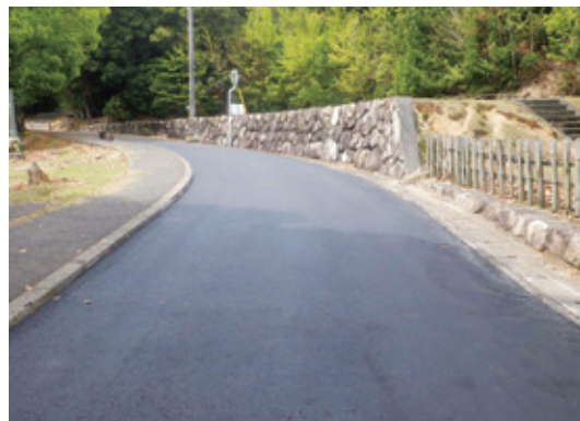
舗装補修後（市道包ヶ浦大砂利線）
