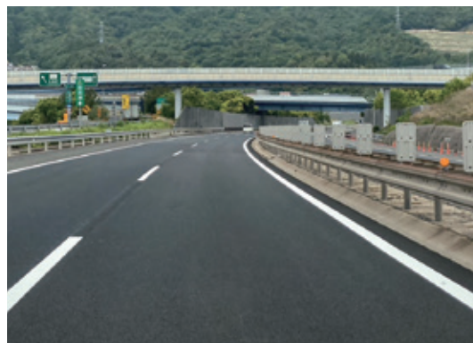
舗装補修後（山陽自動車道）
