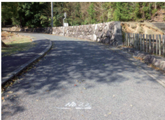
舗装補修前（市道包ヶ浦大砂利線）
