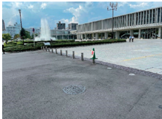
マンホール補修後 (平和記念公園)
