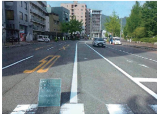
舗装補修後（蔵本通り）
