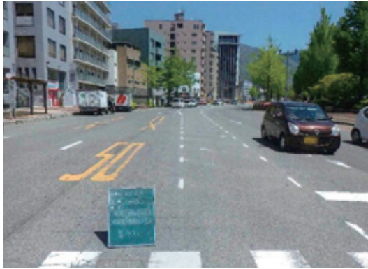
舗装補修前（蔵本通り）
