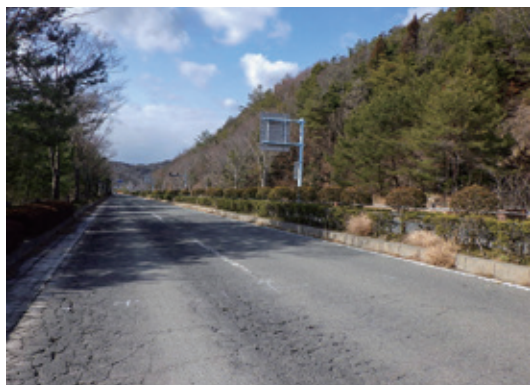
舗装補修前（広島空港線）
