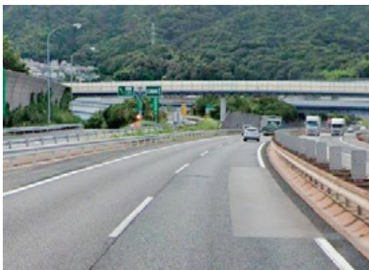
舗装補修前（山陽自動車道）
