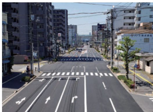
舗装補修後（中2区中島吉島線）
