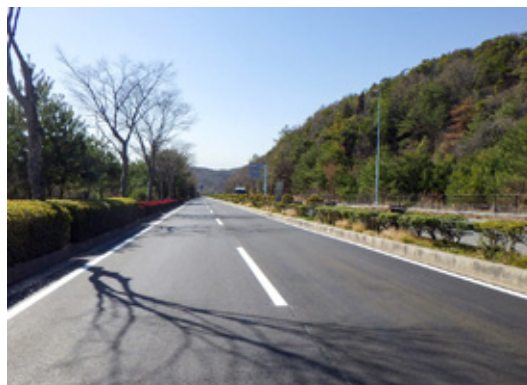
舗装補修後（広島空港線）
