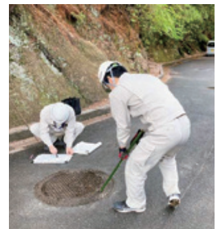
マンホールの確認作業
