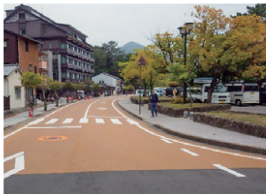
舗装補修後（厳島公園線）
