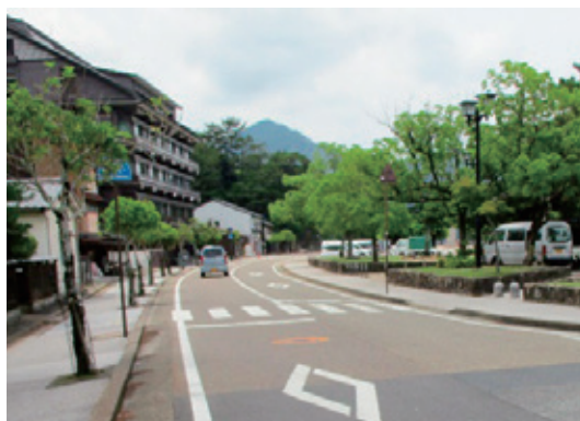
舗装補修前（厳島公園線）
