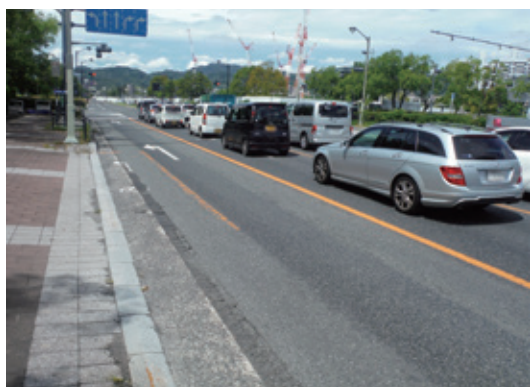
舗装補修前（国道54号）
