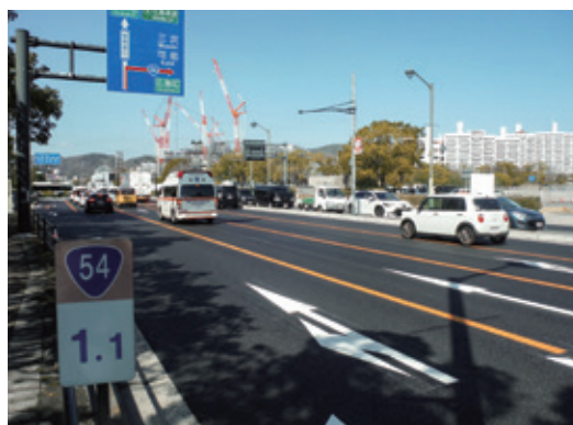
舗装補修後（国道54号）
