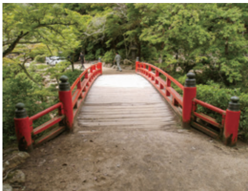
宮島公園内のもみじ橋（着工前）
