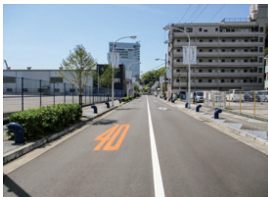
舗装補修後（臨港道路元宇品線）
