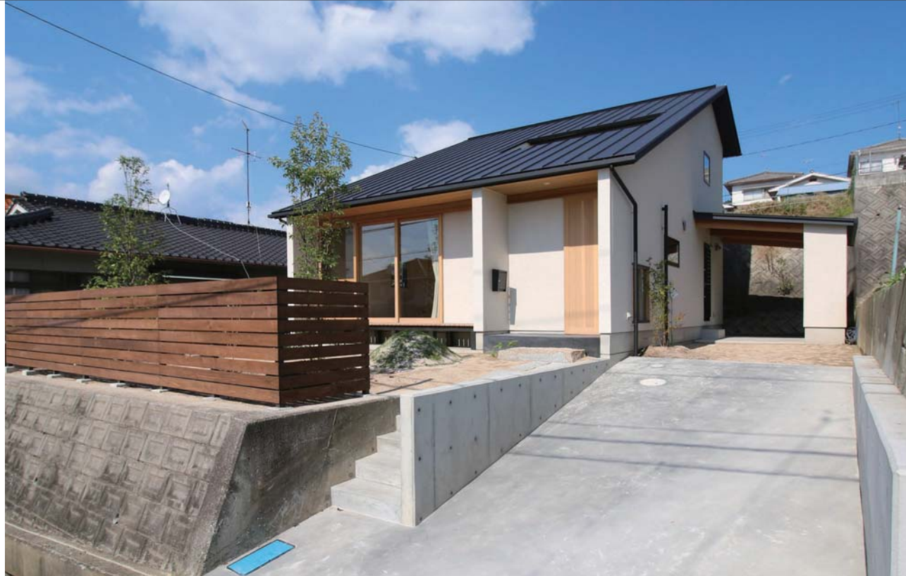
2階まで連続する大屋根が家全体を包み込む。屋根中盤にある穴は寝室前のバルコニーとなっている。
