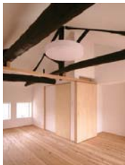
個室1,2。勾配天井によって梁が露出し、古木の存在感が空間を引き立てる。
