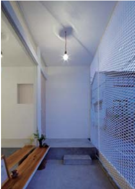
エキスパンドで仕上った壁はアトリエと周辺環境を柔らかく繋いでいる。
