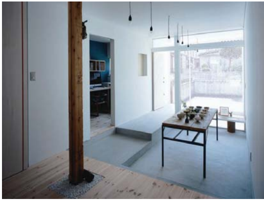
改装前の柱を象徴的に残し、以前の名残を感じられるようにしている。
