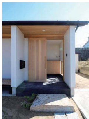
天井いっぴいの玄関引き戸。大きな花崗岩の踏み石とそれに続く土間は墨入りモルタル。軒裏は杉板張り。
