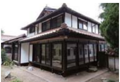
木製建具から、断熱サッシへ変更。床下断熱、及び木部塗装と外壁漆喰の塗り替えも行った。
