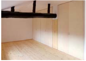
天井高を確保するため、屋根に断熱を施し、勾配天井とした。吹抜けて居間へとつながる。
