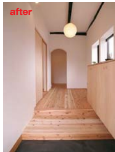
玄関。床の高さを下げ、上がりやすい高さとした。東側に開口を設け、明るさを確保している。
