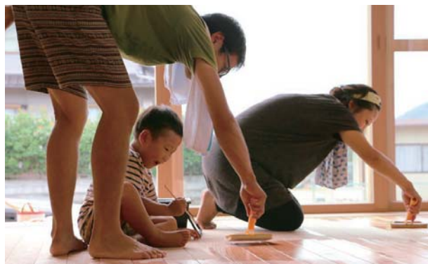
家族みんなで力を合わせて床の塗装。天井材や家具・建具など建築主自らが塗装を行う参加型家づくり。
