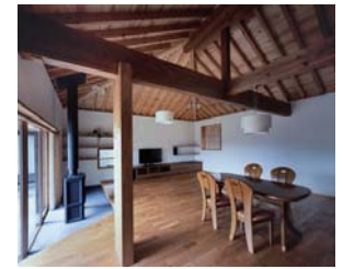
天井は杉板張り30mm、化粧垂木120×60、壁は珪藻土塗り、床はナラフローリング、天井の高さ2.680~4.150。
