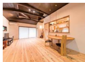
採光と景観を考慮し、南面に掃出しサッシを設置。
