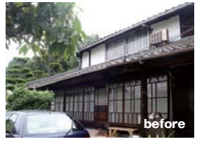
明治時代から変わらず、この地の風景を形作る外観は、そのまま継承した。古来からの漆喰と焼杉の仕上げとした。
