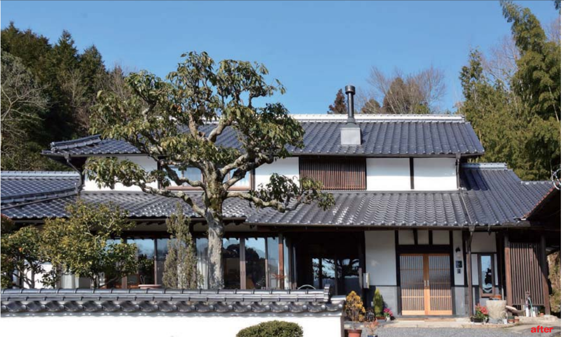
明治時代から変わらず、この地の風景を形作る外観は、そのまま継承した。古来からの漆喰と焼杉の仕上げとした。
