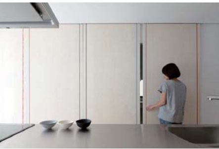
天井まで伸びた扉は長い壁に対して自由に横方向へ動かせる計画にしている。
