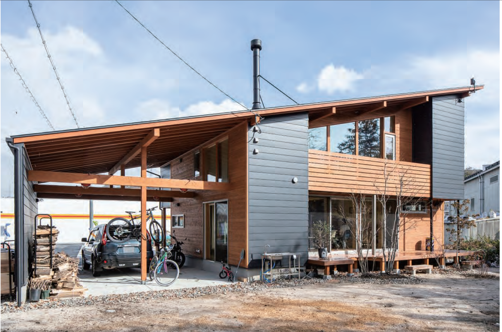
ガルバリウム鋼板と杉板張りの外壁に片流れ屋根を合わせ、別荘のような外観とした。
