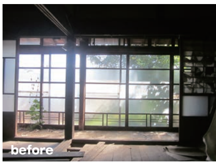
趣ある木製ガラス建具。内部建具はそのまま再利用し、外部建具は室内間仕切りに転用して使い続ける。
