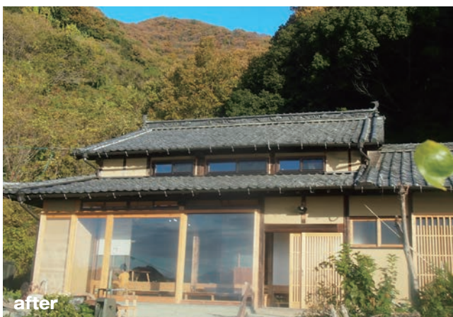
瓦屋根と土壁の意匠は継承し、建具を全て交換した。背後の山に溶け込むよう1階建具は木製とした。
