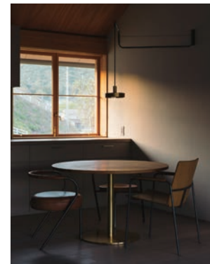
北庭に面する、眺望と通風の確保を目的とした木製窓。レースカーテンを兼ねた麻の横引き網戸を製作した。
