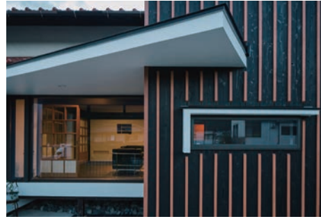
焼杉板と石州瓦色の目板押さえ、そして斜めに伸びた庇が和モダンな印象を与える。
