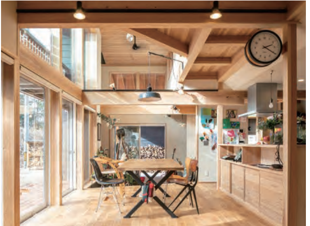
内部の柱・梁、垂木と構造材の多くを現しとし、間仕切りを少なくした。
