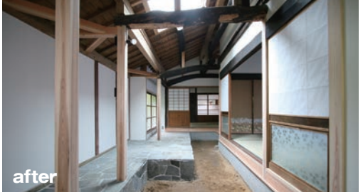
天窓から柔らかく光が差し込む。大広間への間仕切りには既存ガラス障子を転用することで室内へ光が入り込む。
