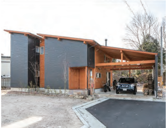
屋根のかかった作業場は、日差しを避けながらの外遊びや、薪のストック場所といった多様な使い方ができる。
