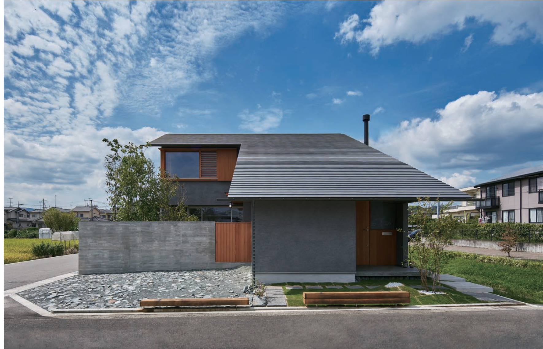
道路に対して軒を低く構えて、軒下に植栽や枕木の欄(腰掛)、鎖樋を配して、道行く人に穏やかな印象としている。
