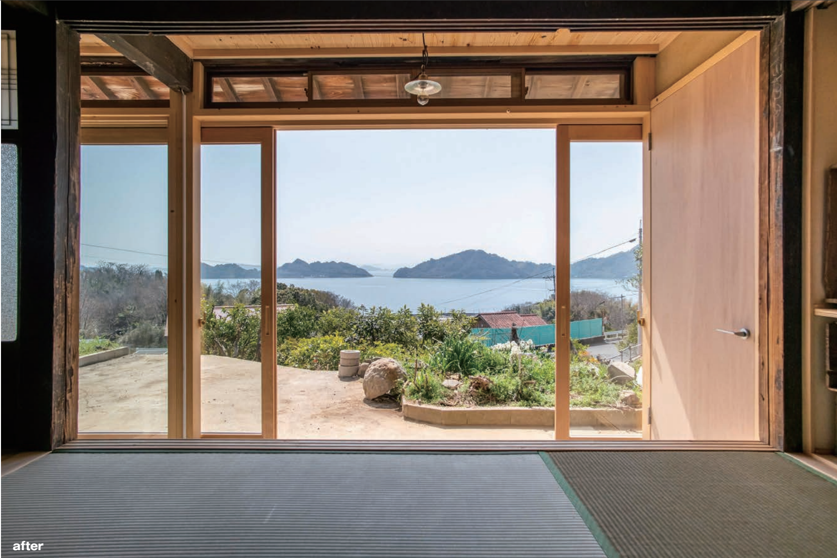
海が見える絶好のロケーションを活かすため、建具を大型の透明ガラスに変更。ペアガラスで断熱性能も向上。
