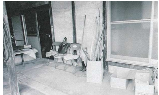
工事前の玄関まわりの状態 ↓
