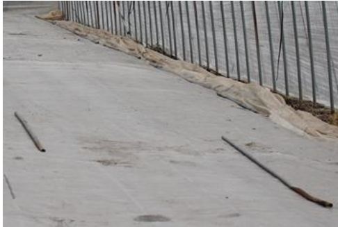
ビニールが浮いている箇所は、鉄パイプ等を置いてよい。
