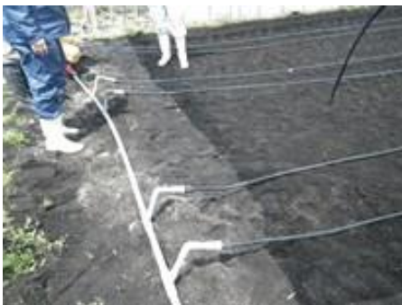
⑤ 灌水チューブの敷設 (写真は散水チューブを80cm間隔)
