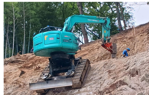
【掘削状況写真】
