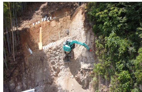
【掘削状況写真】
