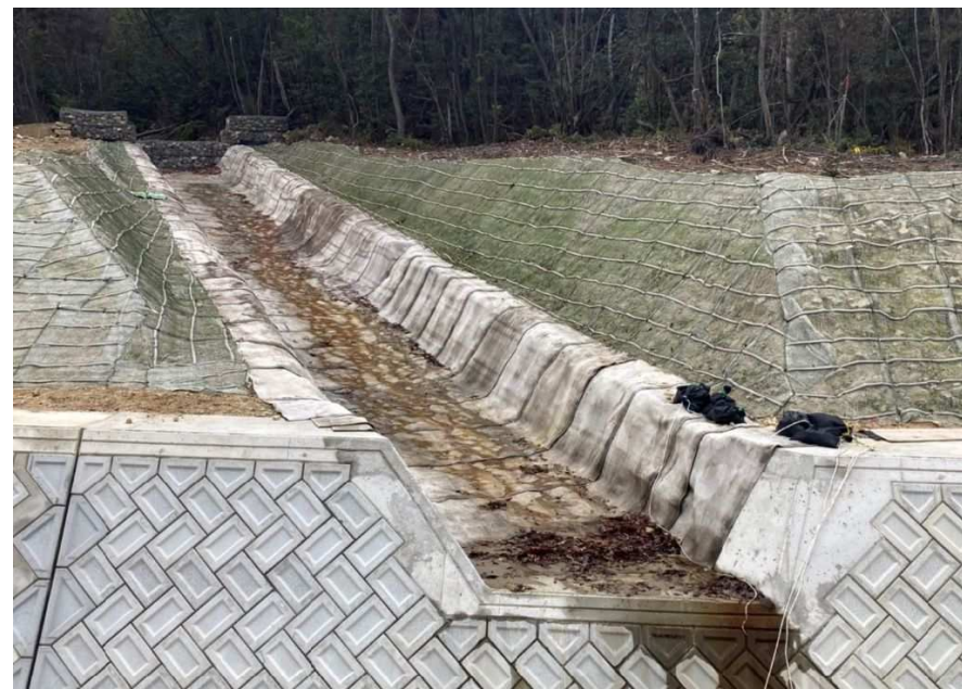
図1.コンクリートキャンバス施工後写真
