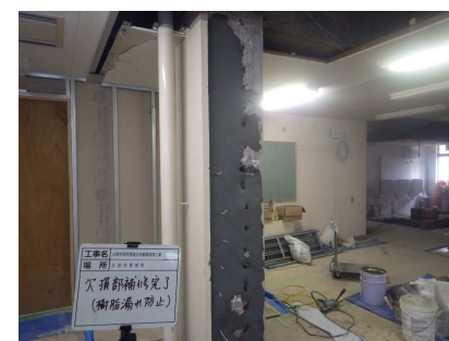
欠損部補修
