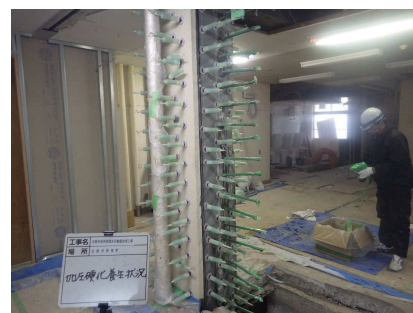
注入 (加圧硬化養生)
