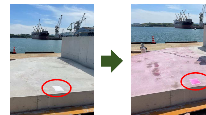
塗布量確認シート施工状況
