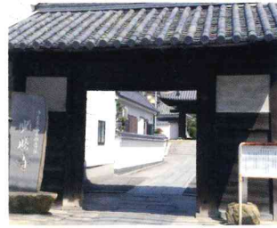
▲B 三原八幡宮 三原城の作事奉行所の門を移築した山門
