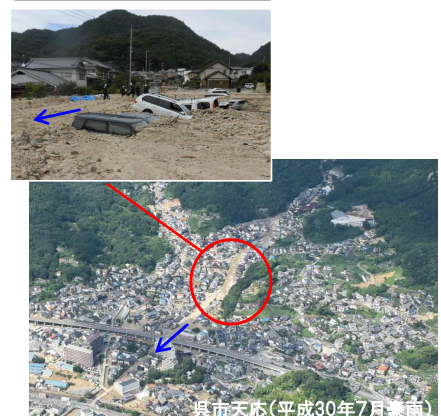
土砂・洪水氾濫の発生状況
