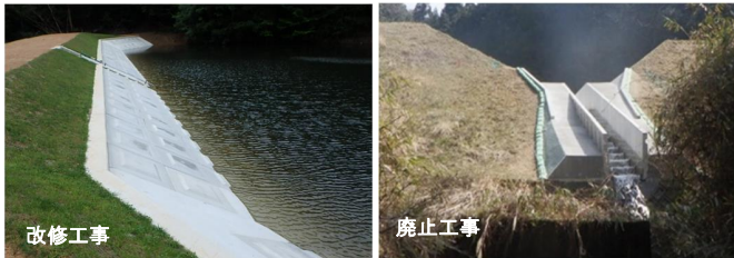
農業用ため池の防災工事
