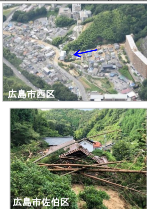
令和3年8月豪雨災害の被災状況
