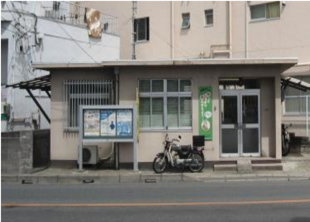
広島南警察署青崎交番（昭和 32 年建築）
