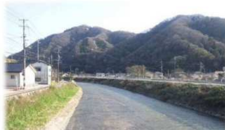
【河川堆積土等の除去】
