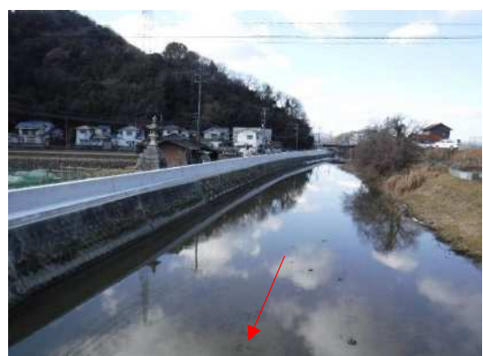
護岸の嵩上げ（天井川：三原市明神）
