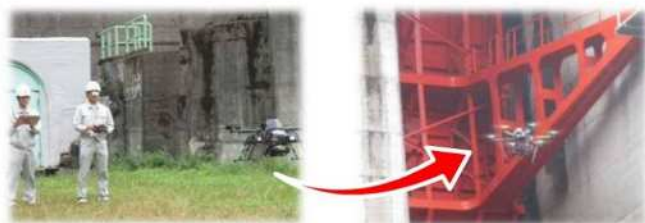
【ドローンを活用した施設点検】
