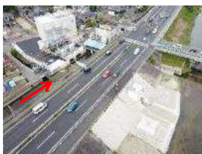
福川排水機場（福山市神島町）
