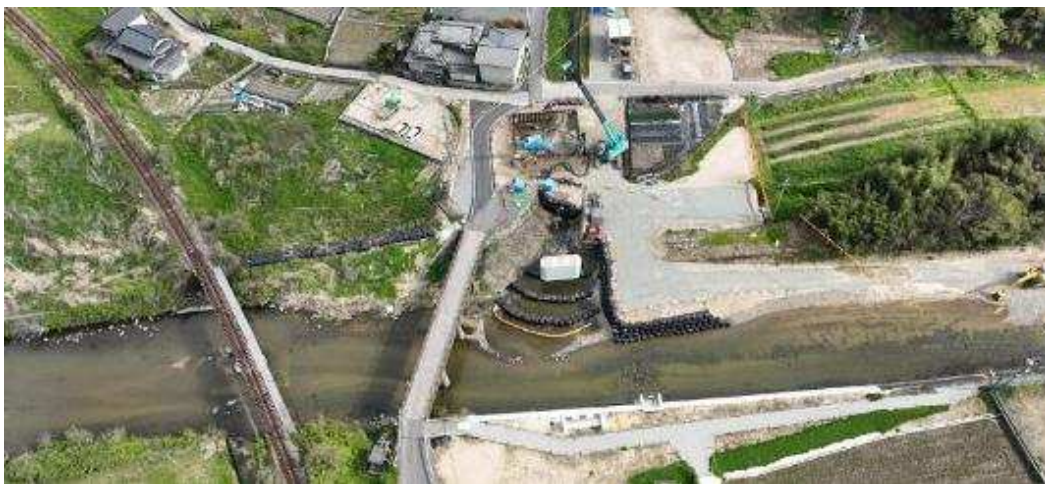
（新）僧殿橋右岸橋台工事
