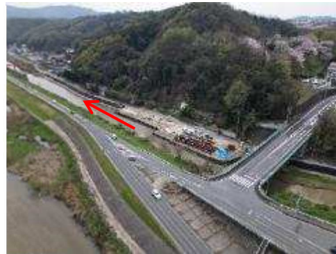
用水管渠敷設工事
