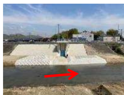
吐出樋門（瀬戸川）
