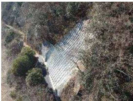
令和5年災 第15号 (一) 奈良備中線 道路災害復旧工事 (神石高原町小野 令和5年12月完成)
