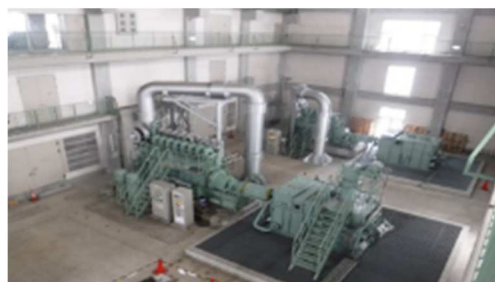
ポンプ増設工事（手城川排水機場内）
