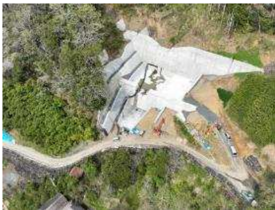
宮ノ間川 砂防激甚災害対策特別緊急工事 (府中市河佐町 施工中)
