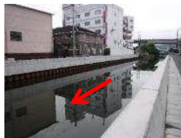
中流域工事（福山市引野町）
