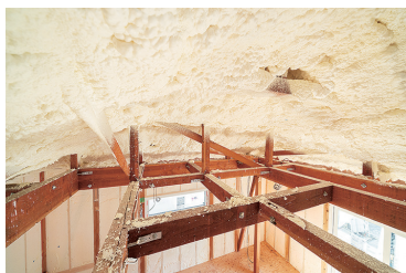
屋根へ断熱材を施工した状態
