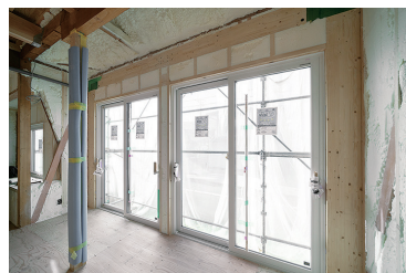
窓も断熱性能の高いものへ取り替えた
