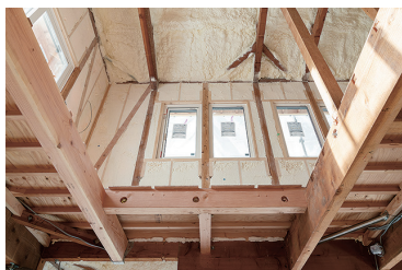
天井と壁にもしっかりと断熱材を施工
