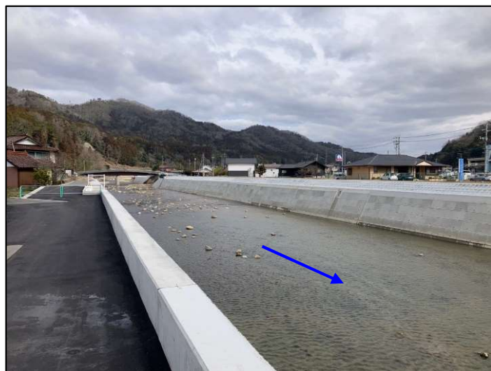
現地写真⑦ (令和6年3月13日完成)
