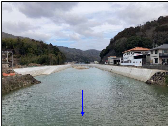
現地写真① (令和6年3月13日完成)
