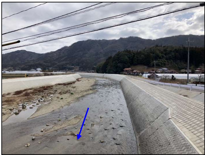
現地写真⑪ (令和6年3月13日完成)
