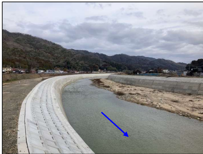
現地写真③ (令和6年3月13日完成)
