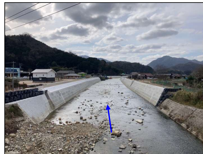
現地写真⑧ (令和6年3月13日完成)
