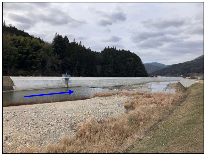
現地写真⑫ (令和6年3月13日完成)
