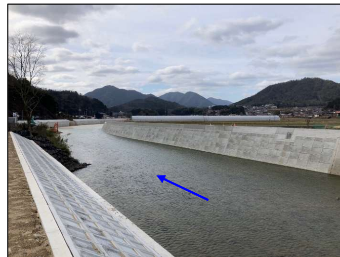
現地写真⑥（令和6年3月13日完成）
