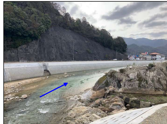
現地写真② (令和6年3月13日完成)
