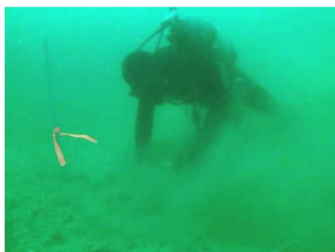
整備箇所の潜水調査
