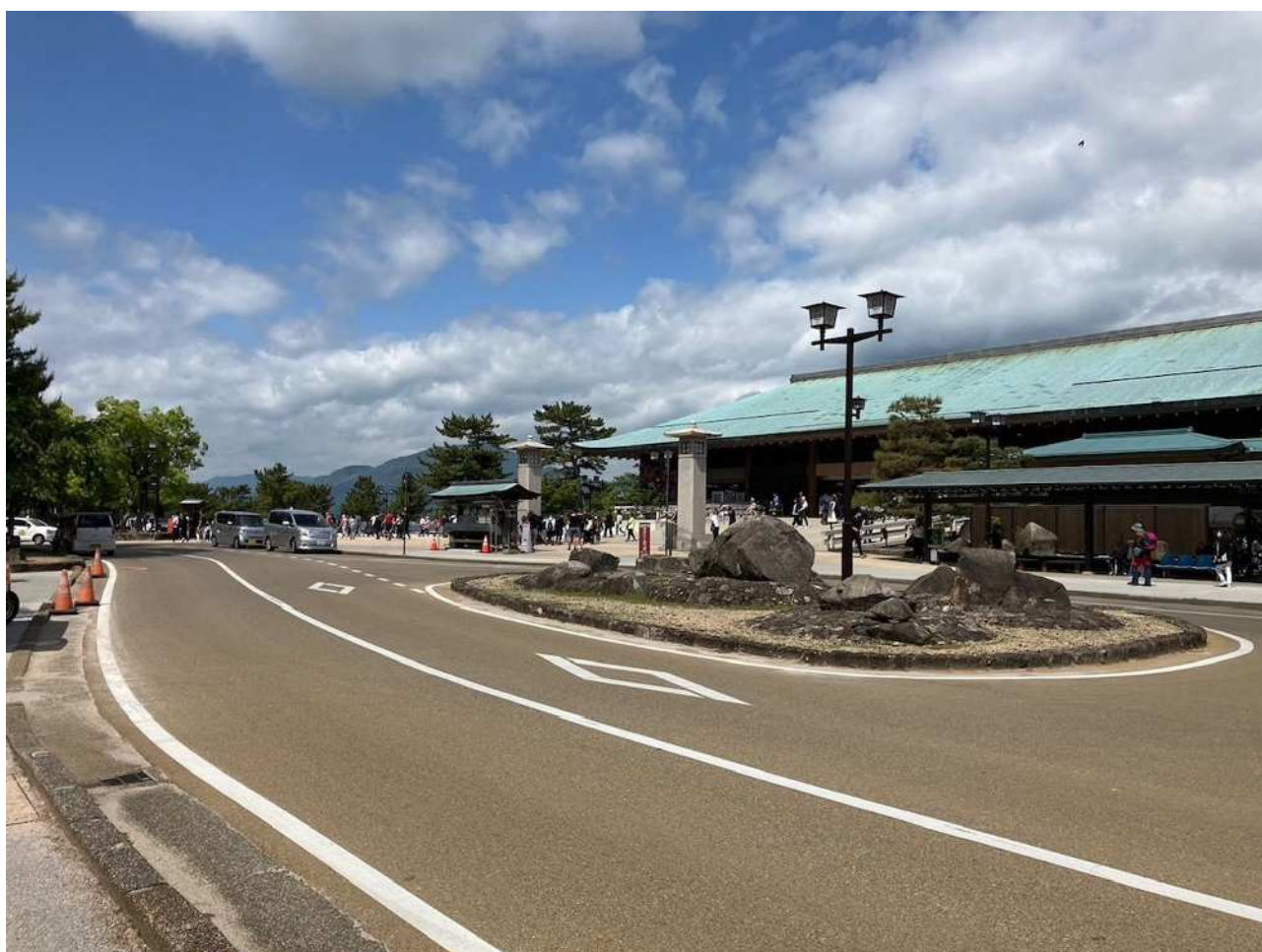
G7広島サミットにかかる道路の環境整備（舗装補修）
