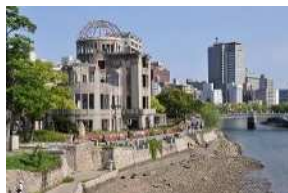
第2位 原爆ドーム (広島市)
