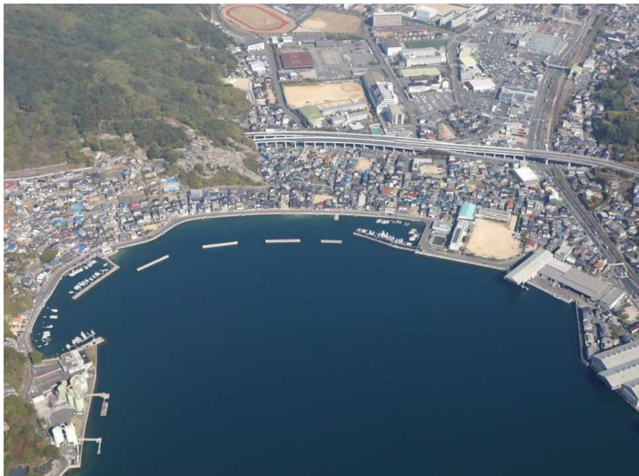
港湾海岸保全施設整備事業 広島港坂地区（安芸郡坂町）
