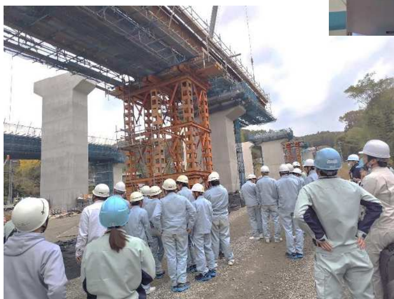
学生向け建設業現場見学会 (福山沼隈線道路改良工事)
