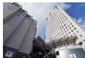
第5位 NTTクレド基町ビル (広島市)
