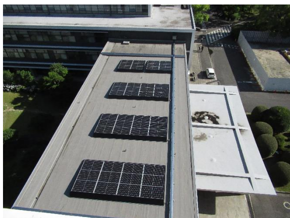
③ 玄関棟屋上
