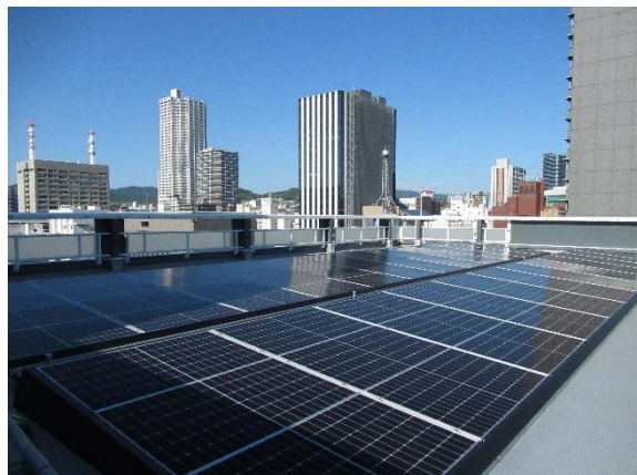
② 本館屋上（東側）
