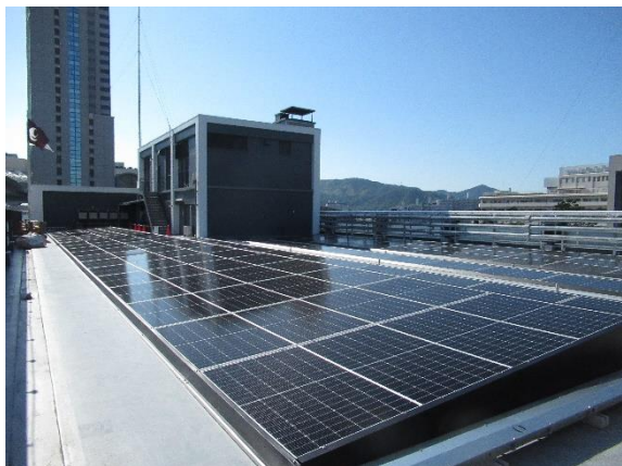
① 本館屋上（西側）
