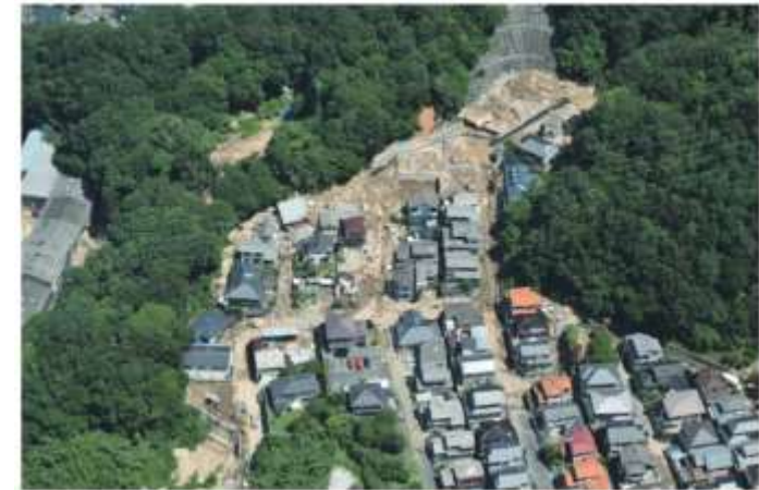
土砂崩れ（広島県広島市安芸区）
