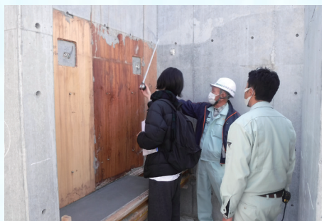
工事監修の様子
