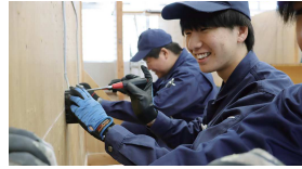
電気工事実習
