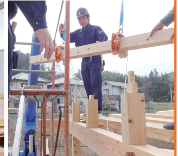
模擬家屋棟上げ実習
