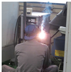
被覆アーク溶接作業
