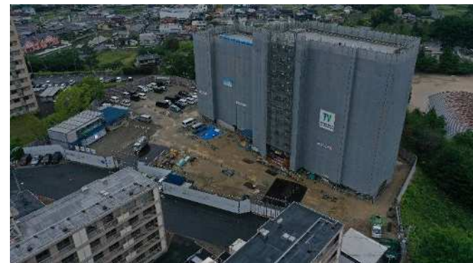
工事中(南ブロック1期新築工事)
