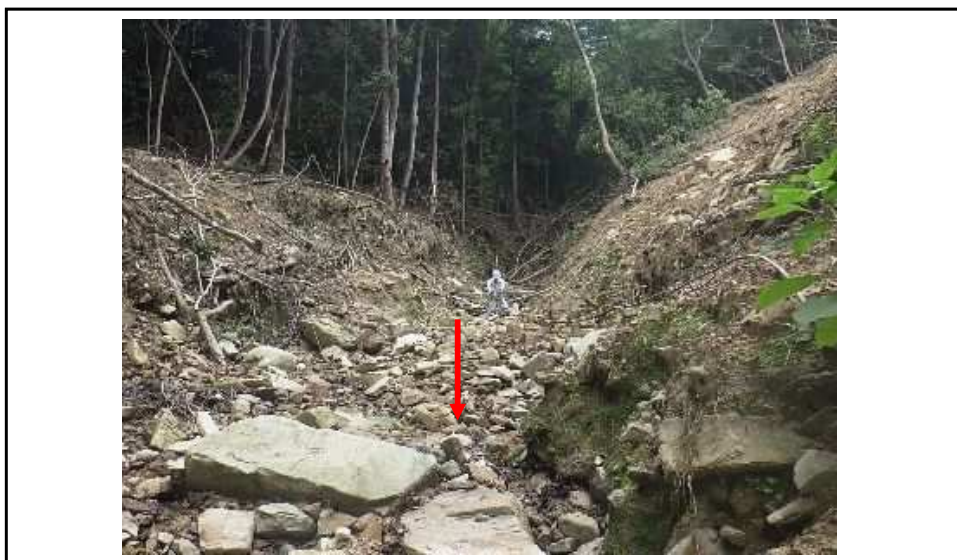
整備前(平成30年7月)
