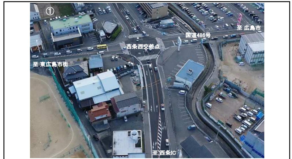
整備後(令和6年4月)
