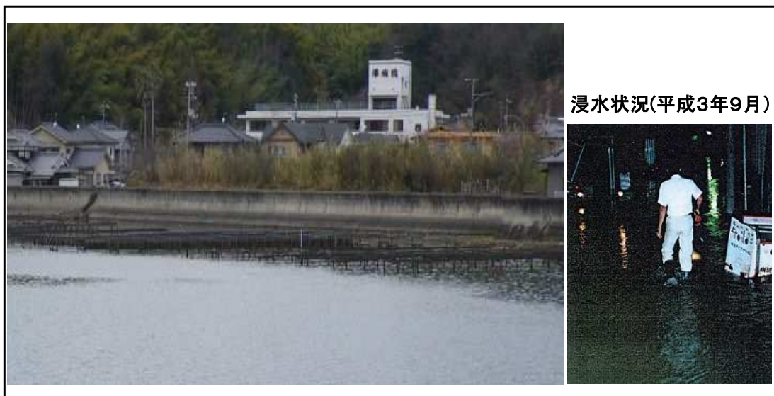
整備前(平成21年2月)
