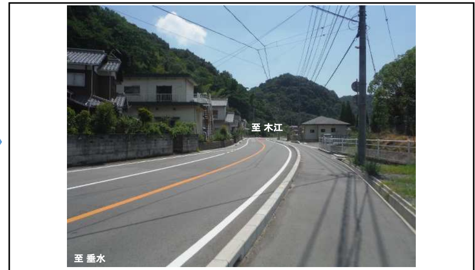
整備後(令和5年5月)
