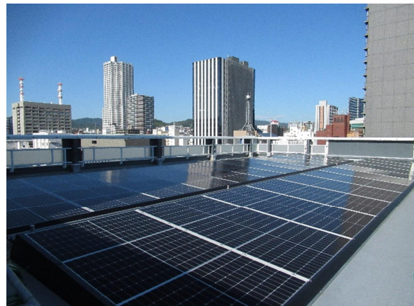
② 本館屋上（東側）
