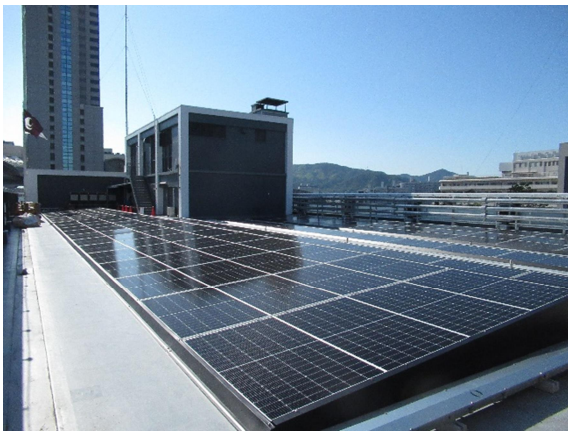
① 本館屋上（西側）
