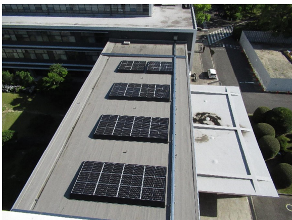
③ 玄関棟屋上
